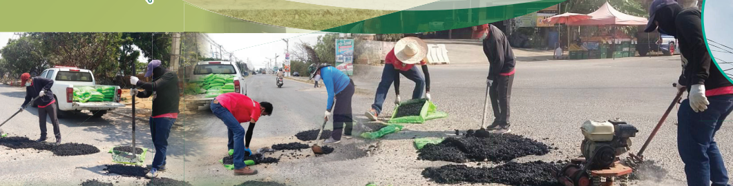
ซ่อมปะผิวทางชำรุด ช่วงเดือนกุมภาพันธ์ - มีนาคม ๒๕๖๕ กองช่าง อบต.หนองระเวียง ซ่อมปะผิวทางที่ชำรุดเสียหาย ถนนเขตอุตสาหกรรม สุรนทรี เพื่อให้ประชาชนที่สัญจรผ่านเส้นทางได้สะดวก
